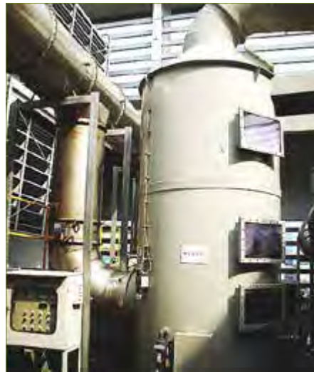
中央洗滌塔照片
