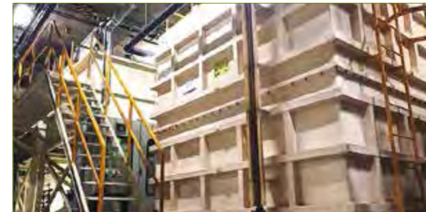
廢水處理系統
